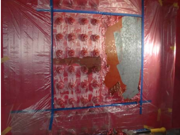
図 A2.1 塗膜剥離剤によるもの
