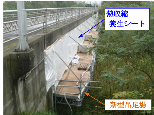
(a) 橋梁側面の状況
