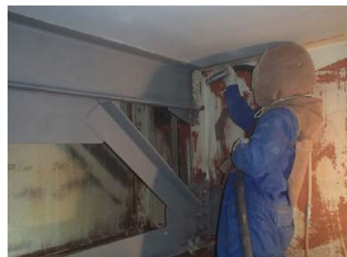
図-解 3.2.5 ブラスト作業時における作業者の防護
